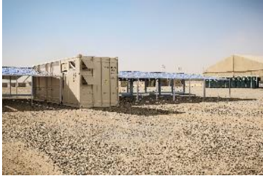
Photo 1: Verleiht Flügel: Diese containerbasierte Stromversorgung von Faber Infrastructure versorgt den ACE-Schulungsraum.
