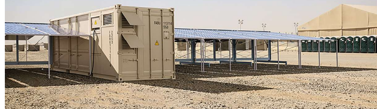
Mobiler Solarcontainer zum Einsatz für netzferne Regionen. (Foto: Faber Infrastructure GmbH)
