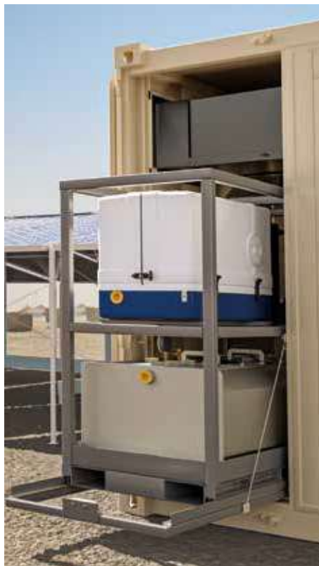
Die modulare Bauweise ermöglicht einen optimalen Zugriff auf sämtliche Funktionseinheiten – im Bild die 24/7-Notstromeinheit
